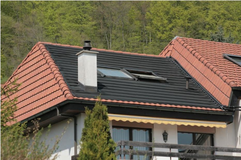
Eine optimale Ausnutzung der Dachflächen zeichnen diese Solaranlagen mit mitras-Absorbern aus, denn diese Dachflächen wurden zu 100 % mit mitras-Absorbern bedeckt.
